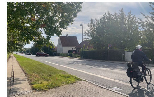
Generelt problem: Cykelbaner for for smalle og kun adskilt fra bilerne med en opstriking. Det er derfor utrygt at være cyklist.
